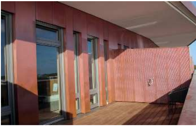
Fassadenkassetten mit Trennwand am Hotel-Staffelgeschoss
