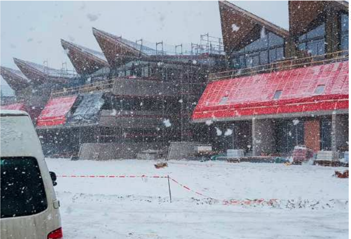
... von wegen Karibik: Tiefster Winter erschwert die Bauphase
