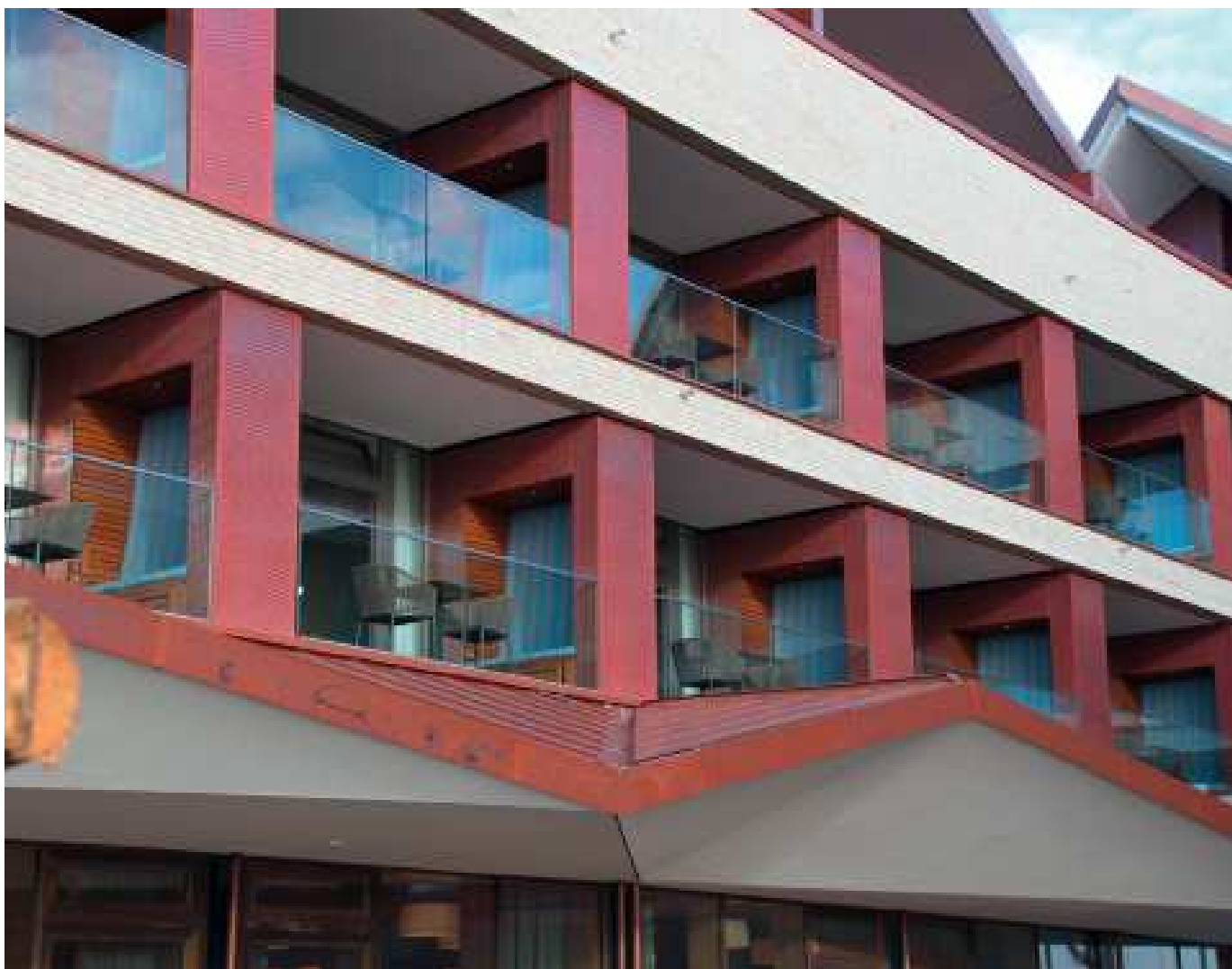
Ansicht der mit Kupfer bekleideten Starndkörbe die zugleich als Trennwandelement genutzt werden
