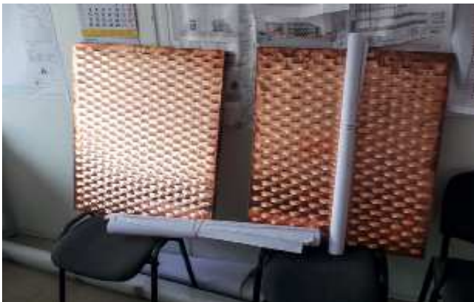
Bemusterung einzelner Kupferelemente mit geprägten Maschen
