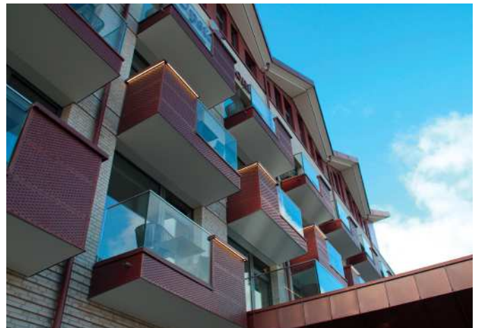
Nordansicht: Balkonbrüstungen mit Glas und „Streckmetall-Masche“
