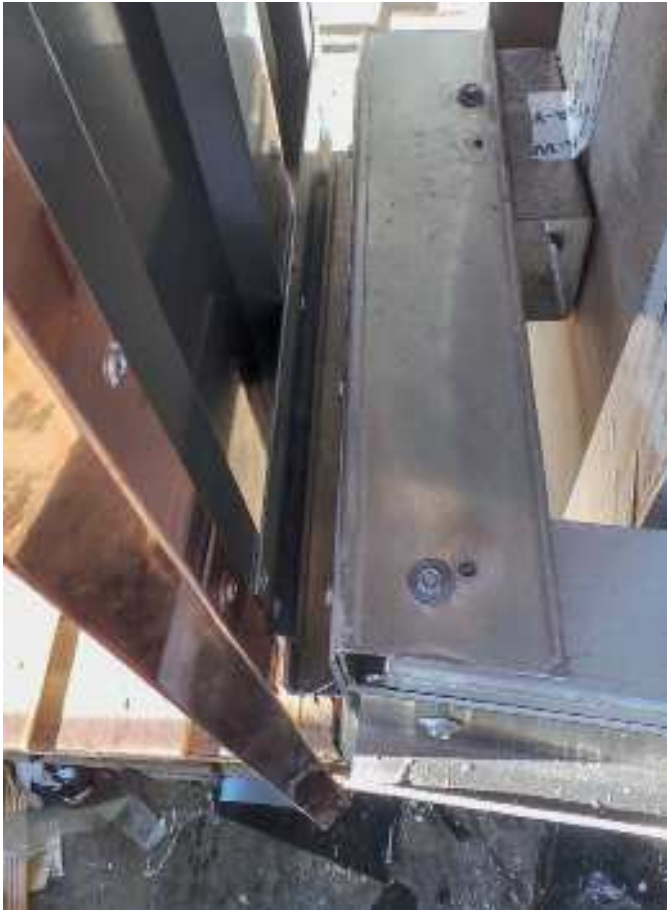
Unterkonstruktion: Detail der Kassettenrückseite (Bild 1)
