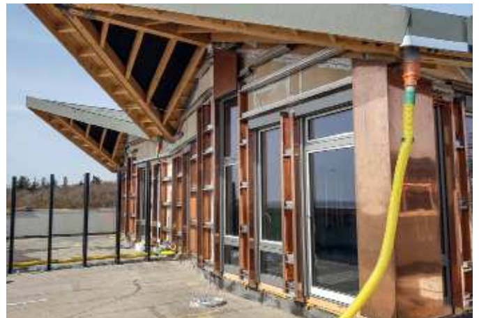
Unterkonstruktion und ertse montierte Kassetten am Staffelgeschoss
