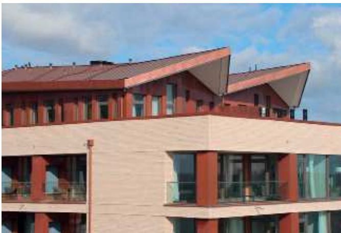
Staffelgeschoss mit Kupfer-Glattblechkassetten bekleidet
