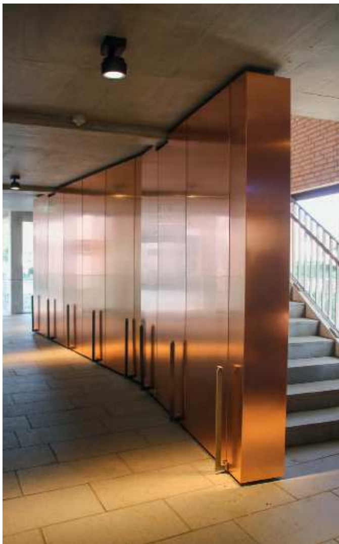
Extrem anspruchsvoll: Montage der Wandbekleidungen im Treppenhaus
