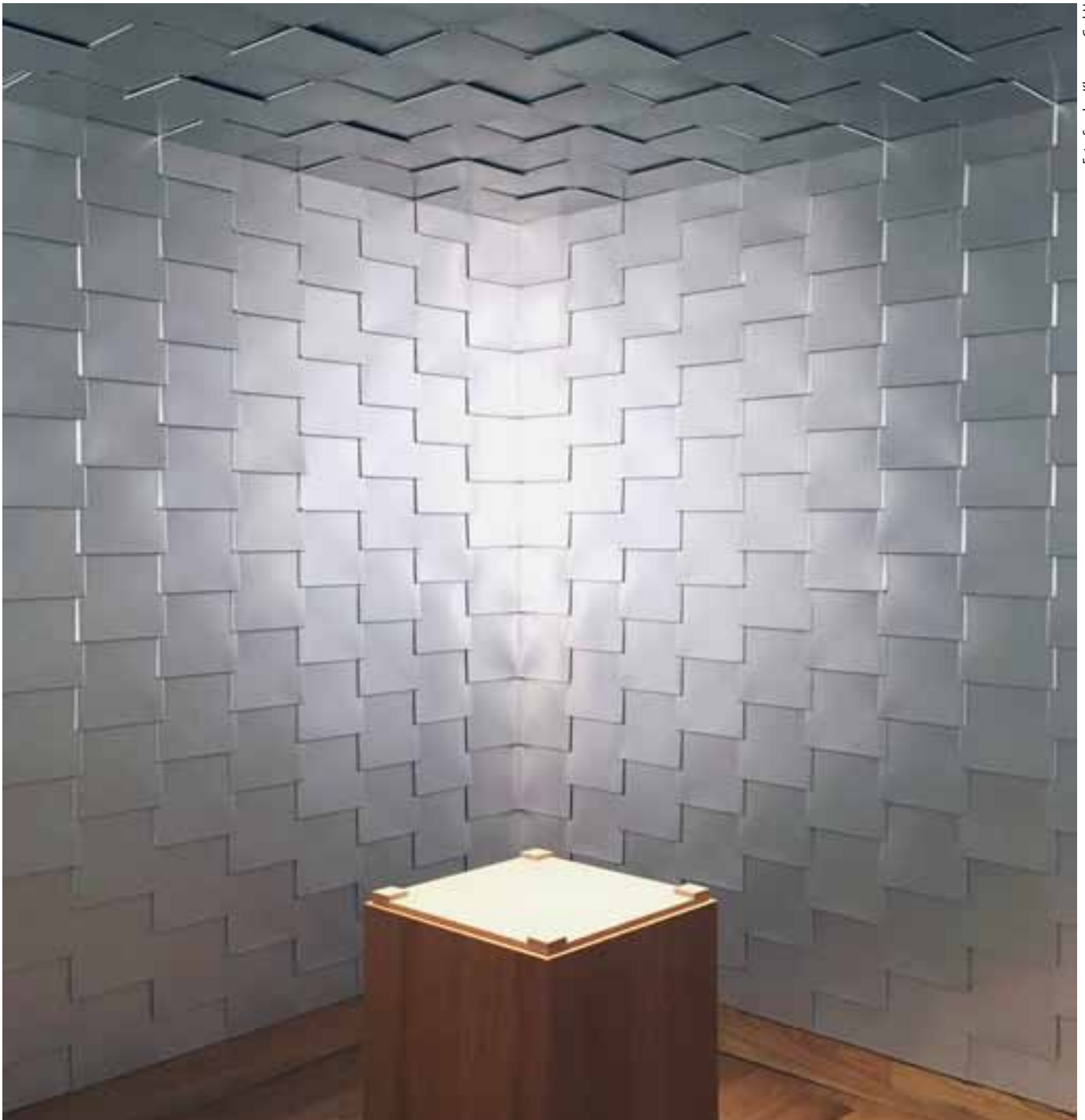
Zusammen mit der Firma Sperber Klempner präsentierten sich Schulz und Schulz bei der Architekturausstellung Biennale 2018 in Venedig. Mario Horn und Geschäftsführer Jens Sperber entwickelten hierfür eine Art Mosaik, das keinen Start und keinen Abschluss der Schindeln erkennen lässt.
